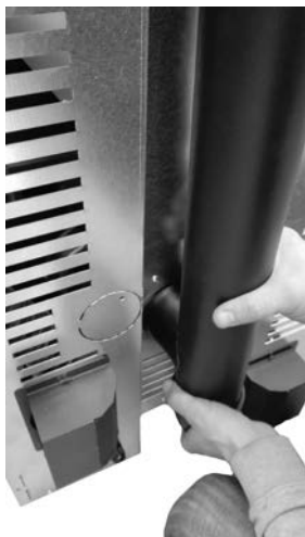
Fig. 54 - Koppel de buis met diameter 80 mm
