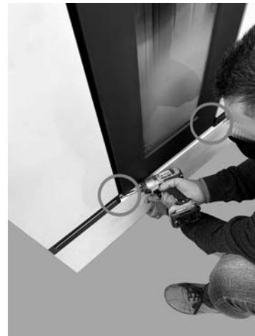
Fig. 44 - Bevestig onderste paneel
