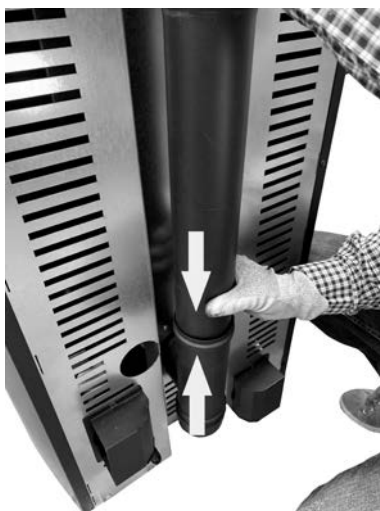
Fig. 51 - Sluit de buizen aan
