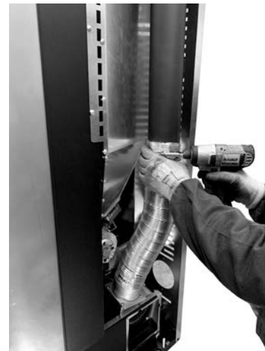
Fig. 64 - Bevestig de buizen
