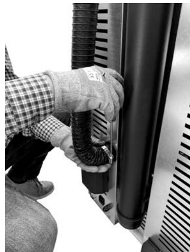
Fig. 55 - Koppel de buis van de verbrandingslucht
