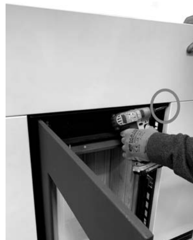
Fig. 41 - Bevestig bovenste paneel
