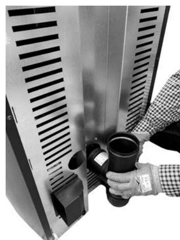
Fig. 49 - Sluit een T-aansluiting aan
